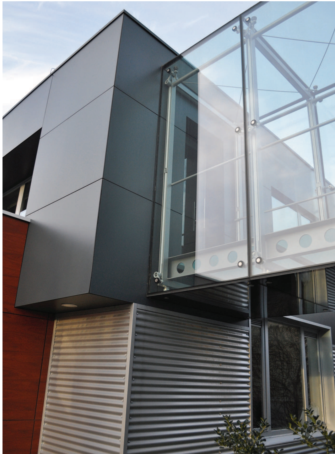
Conception Jonckheere ir-architecten bvba, passerelle en verre et revêtement de façade Beeuwsaert Construct bvba
